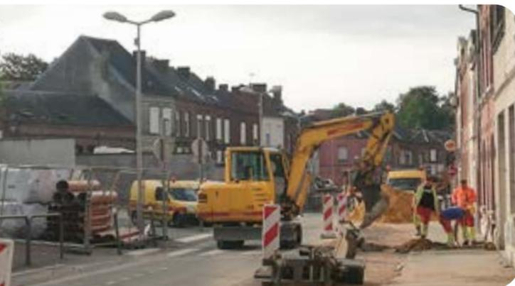
Des conduits de diamètres différents sont placés pour séparer les eaux pluviales des eaux usées chargées
